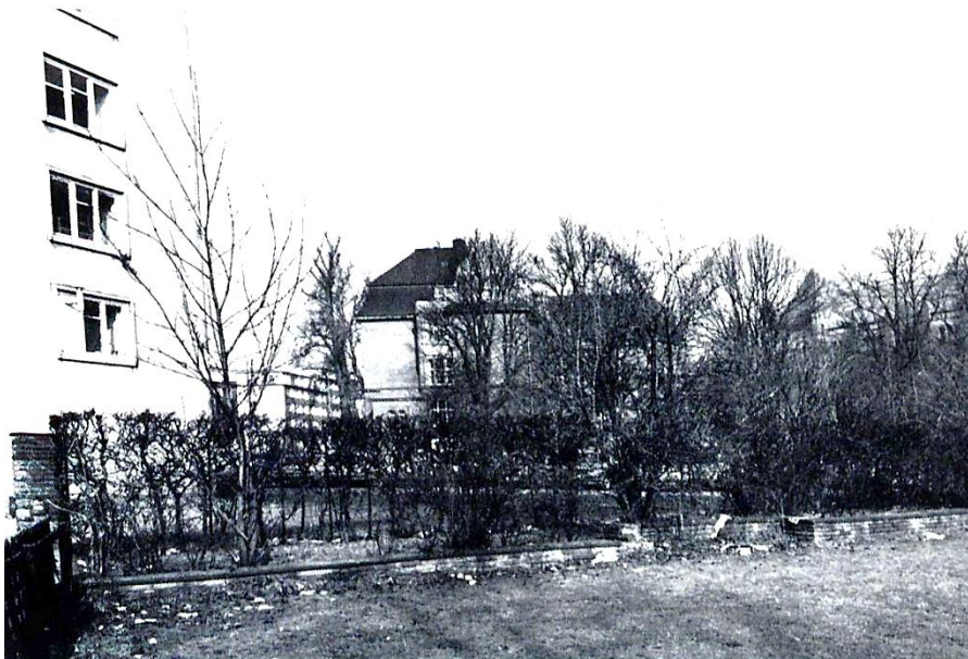
Abb. 4: niedrige Einfriedungsmauer des Grundstücks der Bornplatzsynagoge, im Hintergrund links der Hochbunker, Hamburg, Fotograf unbekannt, erbaut 1906, Aufnahmejahr ca. 1984
